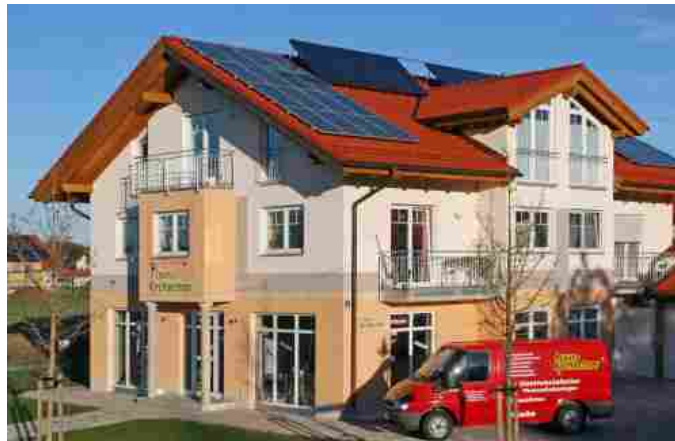
Photovoltaik- und Solaranlage an unserem Geschäftshaus
