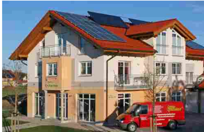
Photovoltaik- und Solaranlage an unserem Geschäftshaus
