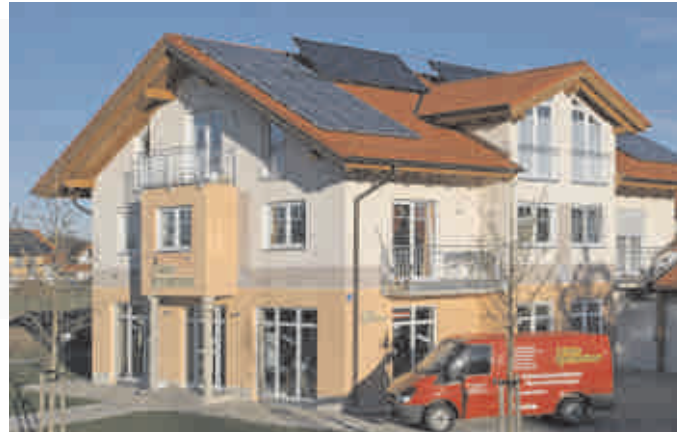
Photovoltaik- und Solaranlage an unserem Geschäftshaus
