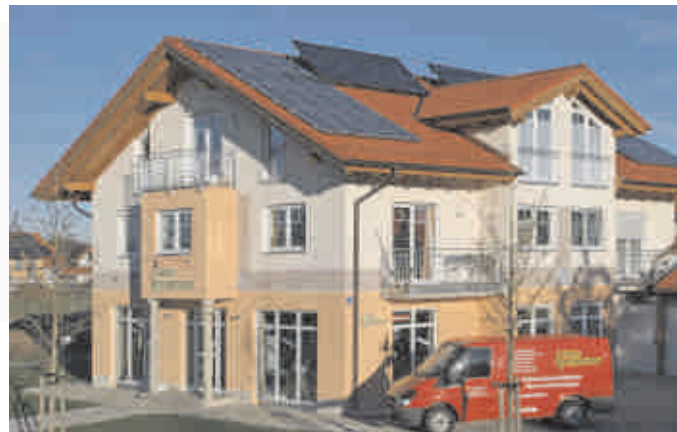
Photovoltaik- und Solaranlage an unserem Geschäftshaus
