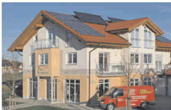
Photovoltaik- und Solaranlage an unserem Geschäftshaus
