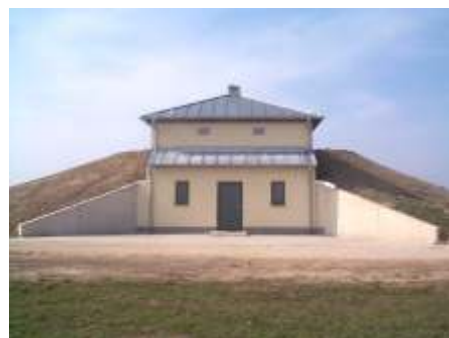
Der neue Hochbehälter Rott a. Inn am Rottberg
